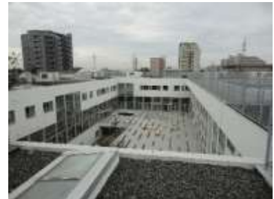
屋上から見た2階デッキ （多様な屋外空間）
