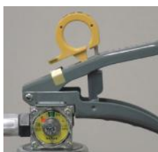
× 安全栓の抜けかけ
