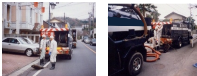
図6-4 点検・調査状況
