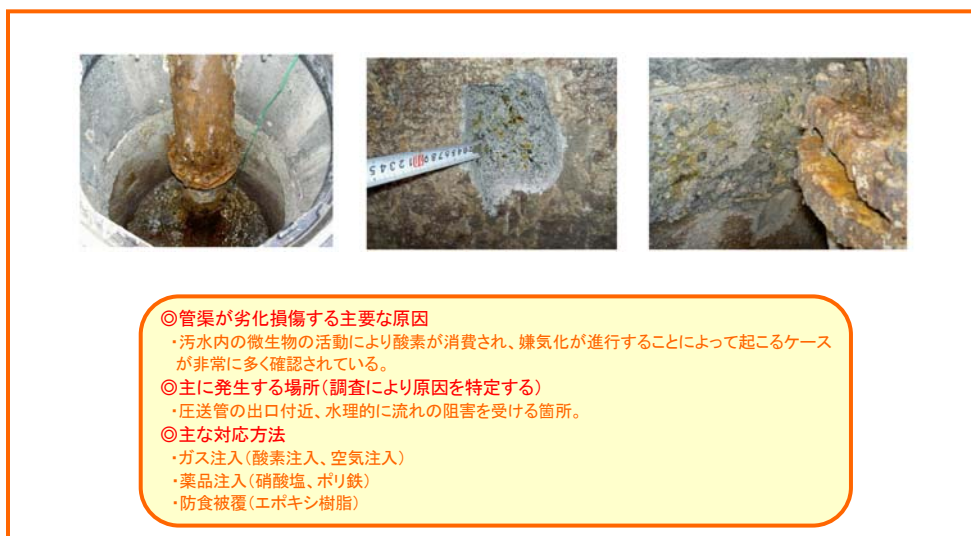
図6-6 管渠施設の調査風景
