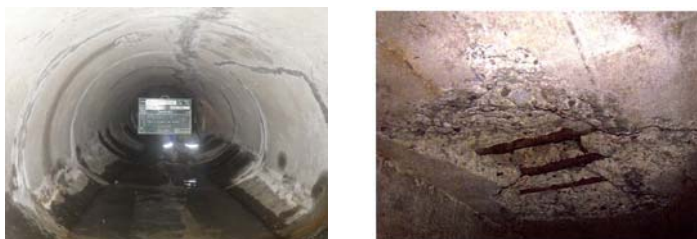
図6-9 目視による点検・調査状況
