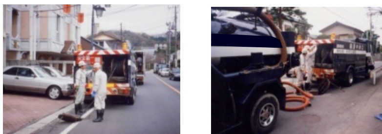
図4-8 管渠の清掃状況
