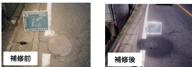
図4-7 マンホール蓋周辺の補修状況
