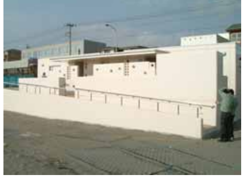
改修後 材木座海岸 第一公衆トイレ
