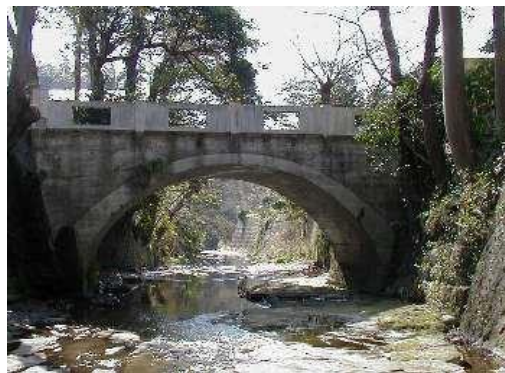
景観重要建築物等 指定第 23 号 東勝寺橋
