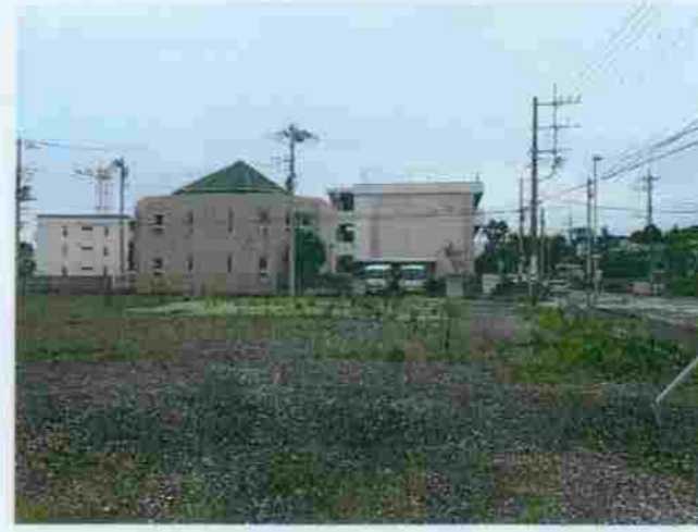
3 敷地南西角から東側全景
