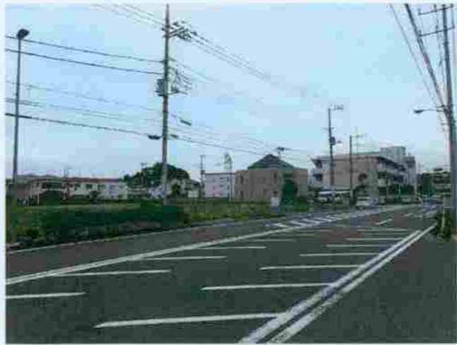
5 南側道路西寄りから東側遠景
