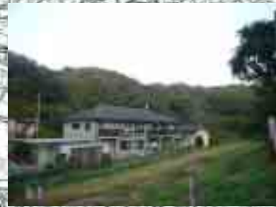
○山崎子供会館入口付近 (駐車場、トイレなど設置予定地)
