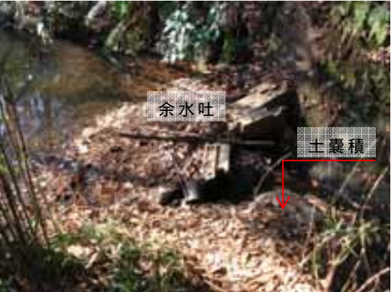
現況余水吐の土嚢積み
