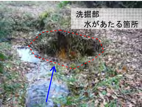
既存U字溝上流部
