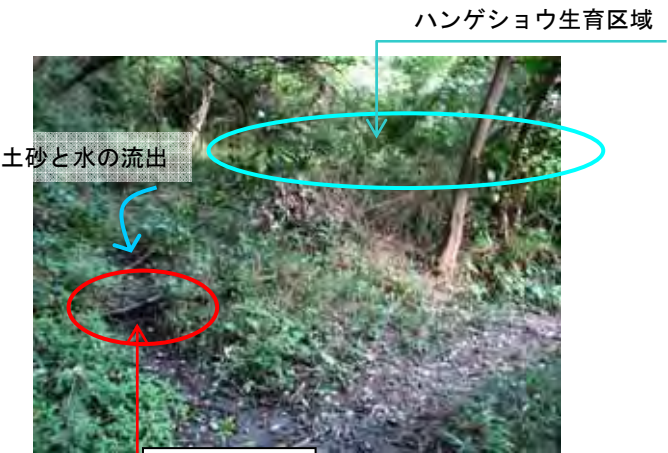
土留め設置位置 (③)
