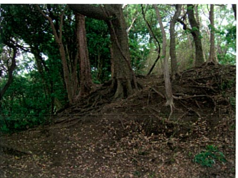
写真. II-2-11 根系が露出しているが、主動線等につながるルートであるため、木階段等の設置が必要
