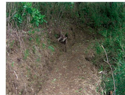
写真. II-2-15 雨水によって洗掘を受けている「みち」
