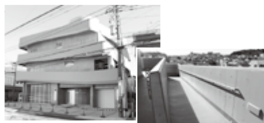
完成した腰越出張所
