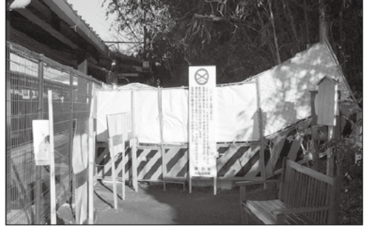
通行禁止としている隧道
