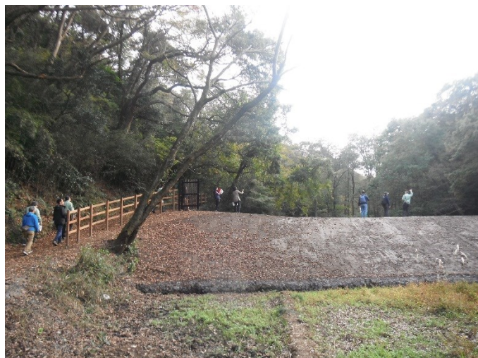
(仮称) 山崎・台峯緑地 ため池の堤体の確認
