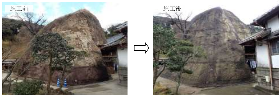
落石を防ぐために落石防止網が張られた山ノ内の斜面 (写真提供：神奈川県横須賀三浦地域県政総合センター地域農政推進課)
