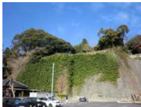
景観に配慮した法面工
