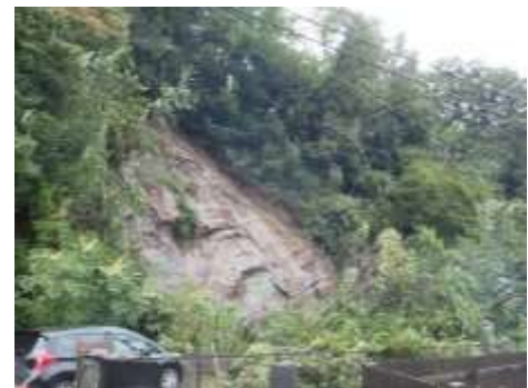
令和元年の台風被害状況(史跡永福寺での土砂崩れ)
