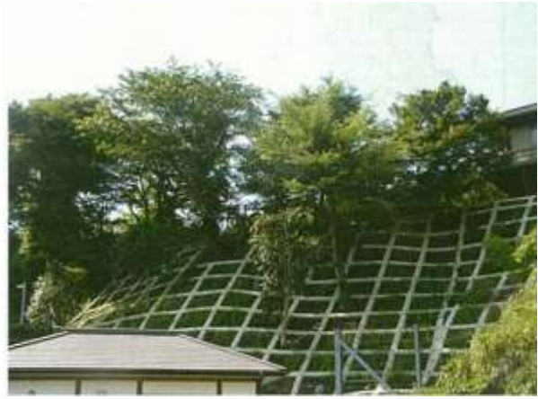
急傾斜地面の防災対策
