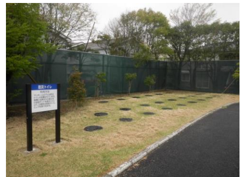
岩瀬下関防災公園の防災施設(岩瀬)
