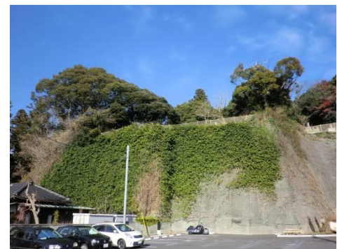
住宅地に面した斜面地における景観に配慮した防災工事(山ノ内)
