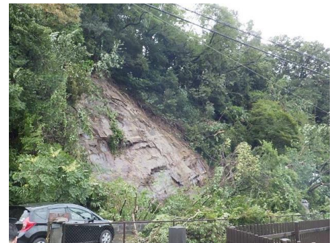
令和元年の台風被害（史跡永福寺跡 二階堂）
