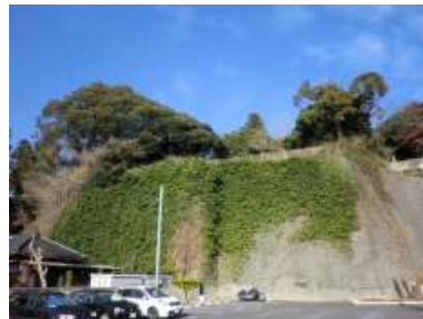
景観に配慮した法面工( )
