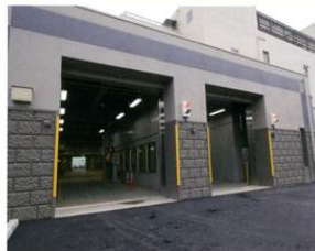
入口計量機 入口計量機をごみ処理施設と一体化し、入口・出口に扉を設けています。
