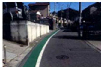
【カラー舗装の例】
