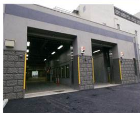
入口計量機 入口計量機をごみ処理施設と一体化し、入口・出口に扉を設けています。
