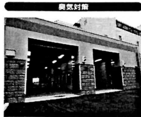
臭気対策 入口計量機 入口計量機をゴミ処理施設種と一体化し、入口・出口に扉を設けています。
