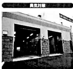
入口計量機 入口計量機をごみ処理施設と一体化し、入口・出口に扉を設けています。
