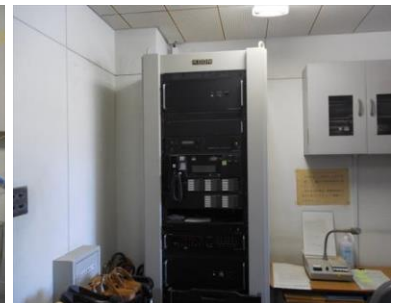
放送設備 アンプ ；1996年に更新されている
