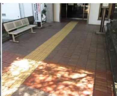
外構タイル舗装 ；部分的張替え改修が実施されている
