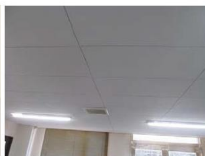
石こうボード目透かし貼りの上 塗装仕上げ
