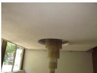
石こうボード貼り継ぎ目処理の上 リシン吹付け
