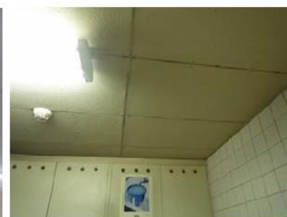
石綿セメント板塗装仕上げ
