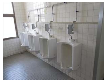
給水管 ；衛生陶器は既存のままで、給水管は更新されている
