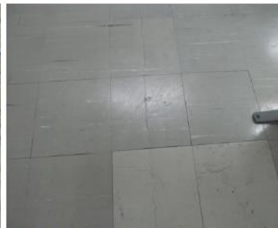
床仕上げ（ビニルタイル） ；部分的張替え改修が実施されている
