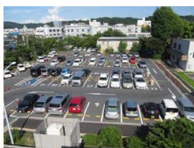
駐車場アスファルト舗装 ；近年改修された様子。不具合は確認されない
