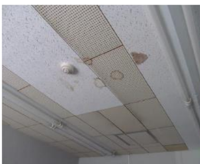
天井仕上げ（吸音テックス） ；部分改修が実施されている
