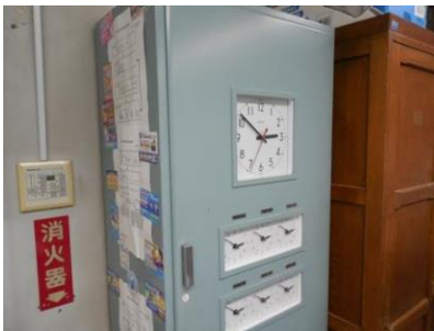
電気時計 親時計 ；更新されている
