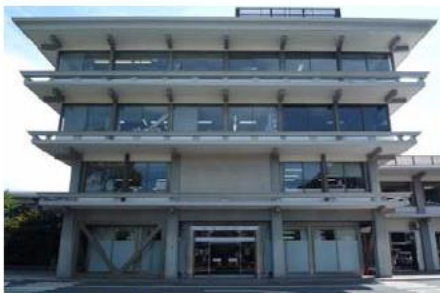
本庁舎外壁全景 ；平成18（2006）年に耐震補強改修及び、外壁改修が実施されている
