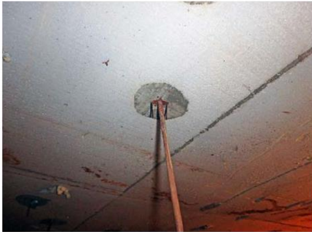
写真13；吊り元・吊りボルト上端の状況。 （スラブ・埋込みインサートにて設置）
