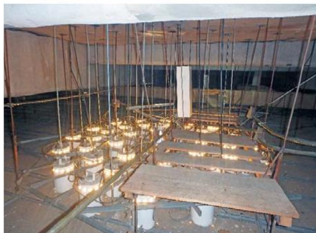
写真8：天井内部 全景 (キャットウォーク①；照明器具中心部上)
