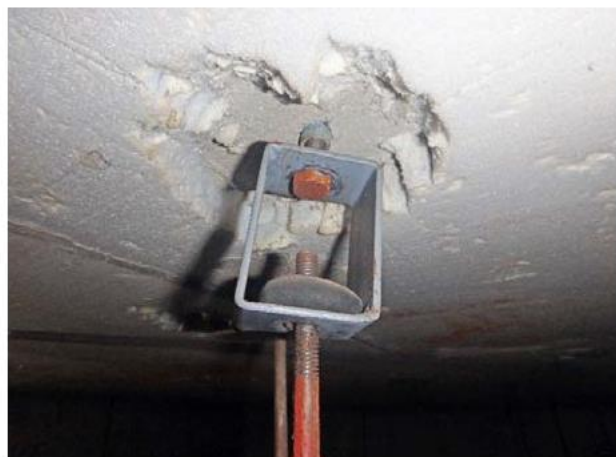
写真36；一部に設備機器用のボルトには、防振ハンガーの設置を確認した。
