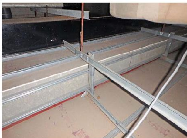
写真27；天井段差部 （段差補強はなし）
