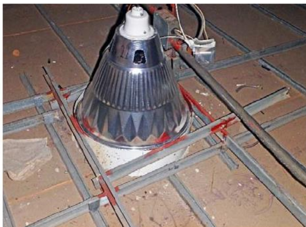
写真29；開口補強部
