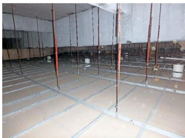
写真10：天井内部 全景 (キャットウォーク②；天井中央部付近)
