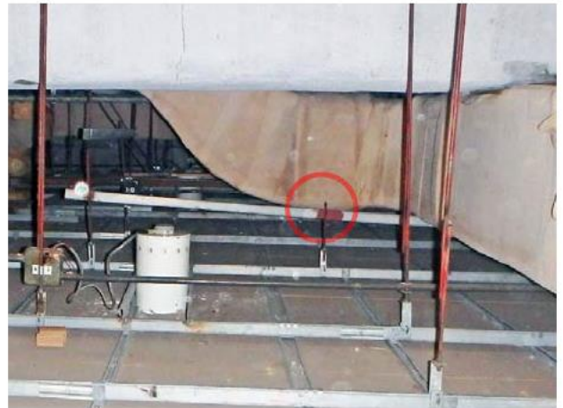
写真14；吊り元・吊りボルト上端の状況。 （ダクトにより吊りボルト間に溶接した 野縁受け材を吊り元として溶接）
