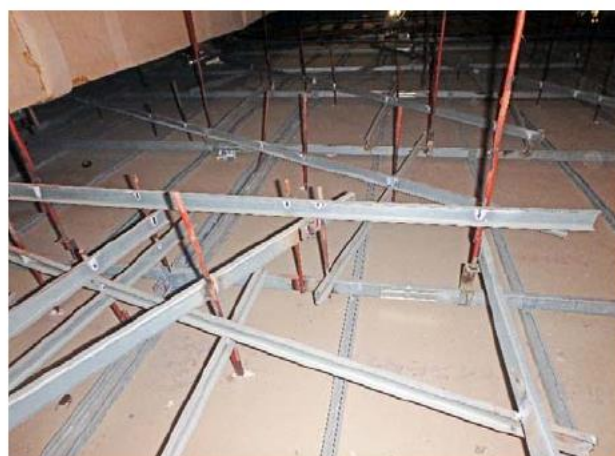
写真28；天井中央照明の支持材（野縁受け材） が放射状に天井の吊りボルトや野縁 受けの上に溶接固定されている。
