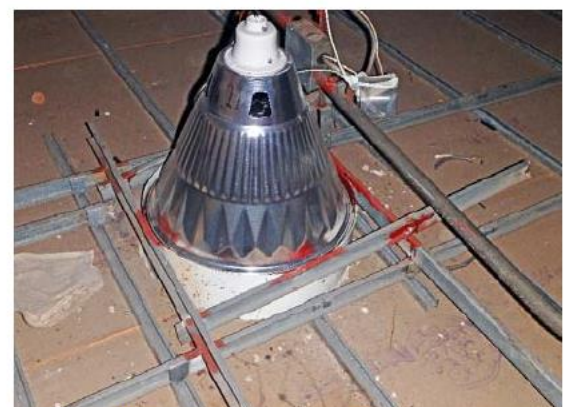
天井照明器具の支持状況 -2
