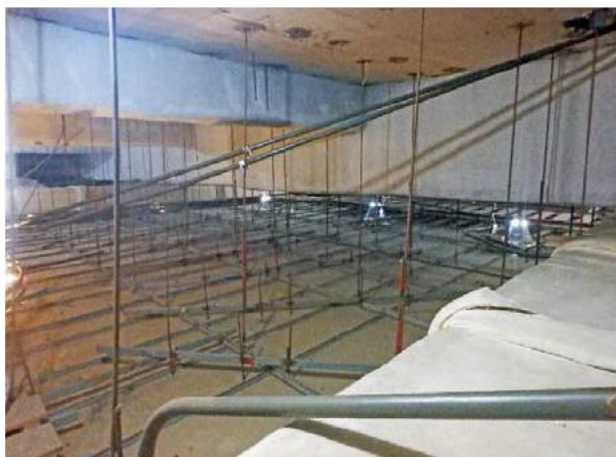
写真7：天井内部 全景 (キャットウォーク①；天井中央部付近)
