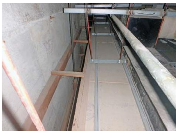
写真12：天井内部 (キャットウォーク①；天井裏入口側端部)
