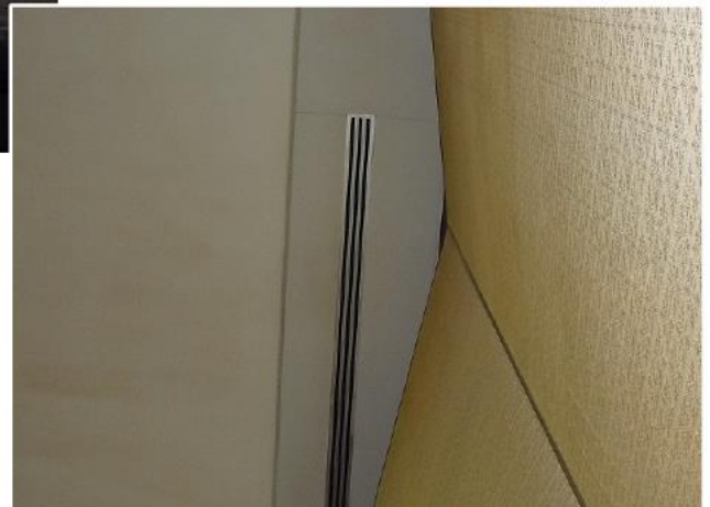
ライン型吹き出し口の状況
