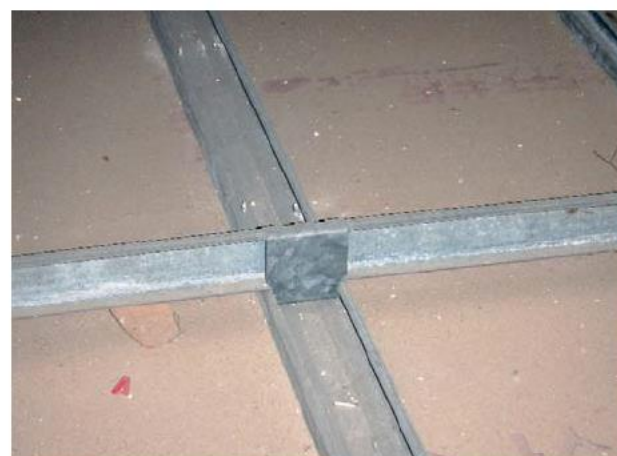
写真22；従来型ダブルクリップ（背掛け） 地震力等の外力は考慮されていない。
