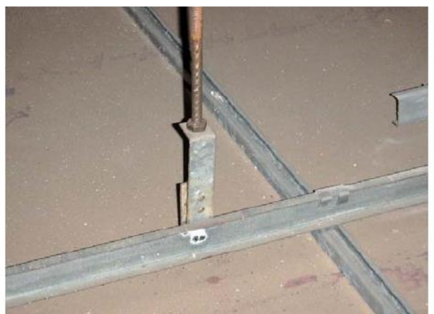
写真18；ハンガーの底面に溶接された野縁受け。
