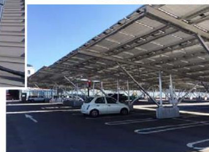
集光パネルの下部を駐車場として利用している事例
