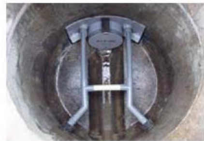
装置-1の設置状況
