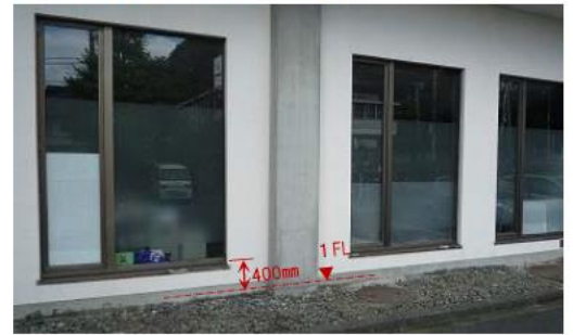
本庁舎1階窓設置高さの状況
