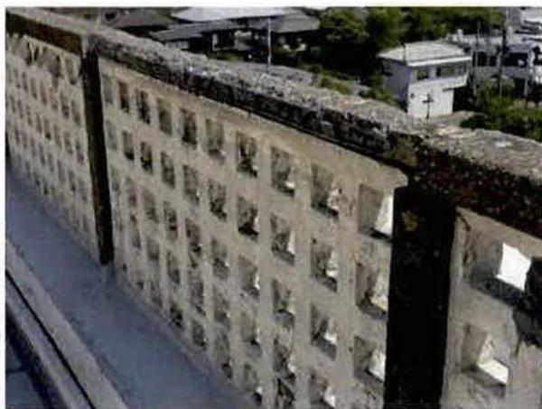
また、コンクリートの中性化についても調査しています。既存庁舎の竣工は昭和 44 年 (1969 年) であり、現時点ですでに築後 54 年が経過しています。劣化調査では、コンクリートの中性化によって、築後 60 年、65 年の段階で、内部鉄筋の発錆を促し、コンクリート自体の爆裂<sup>※用語集</sup>を誘発することで、躯体に断面欠損が生じ耐震性能が低下すること
