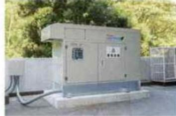
ガス変換機（LPガスと空気を混合）
