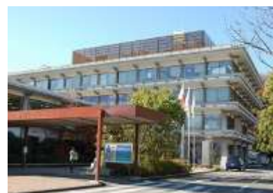
本庁舎（昭和 44 年築）
