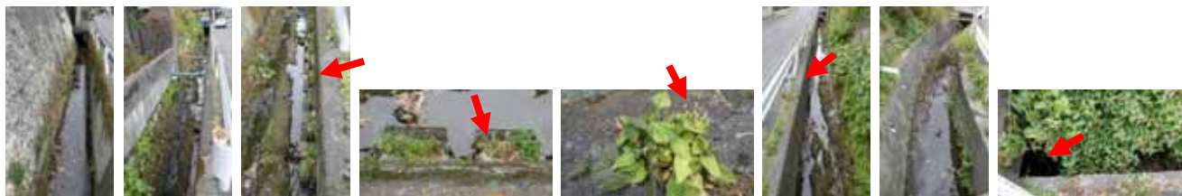
税務署裏 エコアップ箇所 護岸上のスマレ 下流側 元・うな豊前 洗掘進行箇所
