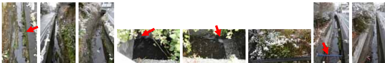
エコアップ箇所 上流側から 元・うな豊前 洗掘進行箇所 泡が見られる 外来種ランタナが繁茂 被覆が流失
