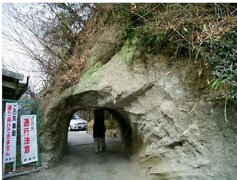
写真 3.4.1 北鎌倉トンネルに側壁部の状況
