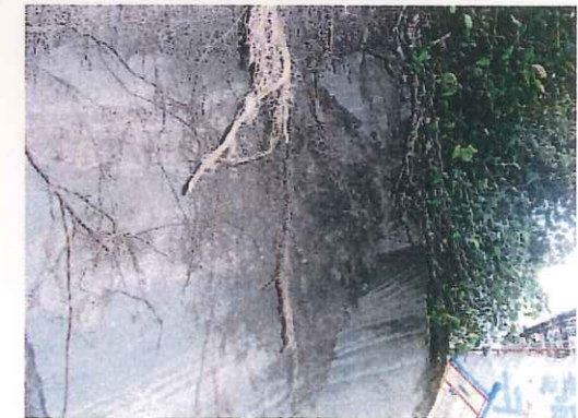
写真 3.3.3 はく落箇所のひび割れに樹木の根が入り込んでいた状況
