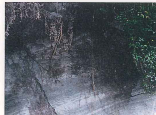
写真 3.3.3 はく落箇所のひび割れに樹木の根が入り込んでいた状況
