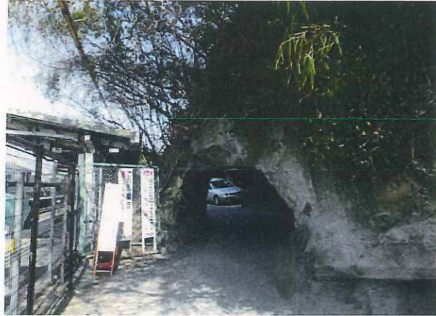
写真 3.3.1 H26.3 鎌倉側坑口状況
