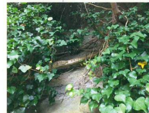
⑤ 大船側坑口上部ひび割れ状況
