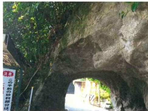
① 鎌倉側坑口状況
