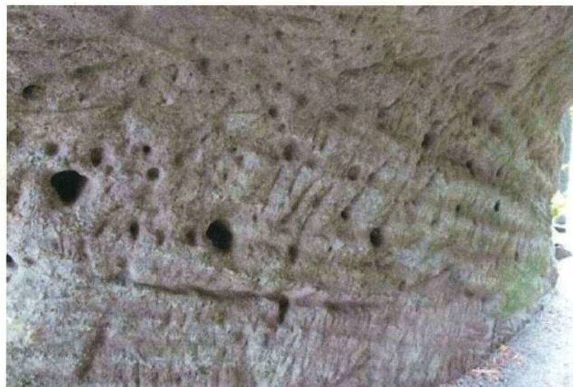
トンネル内部
