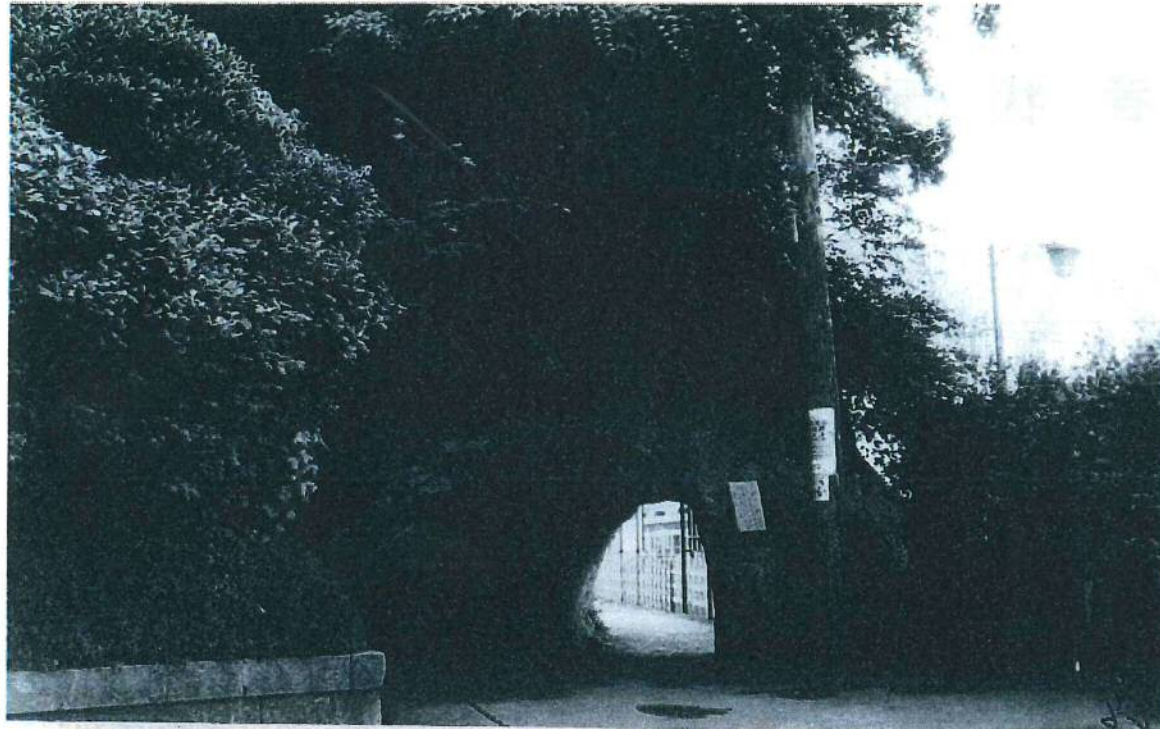
大船側から見た北鎌倉隧道（昭和48年）
