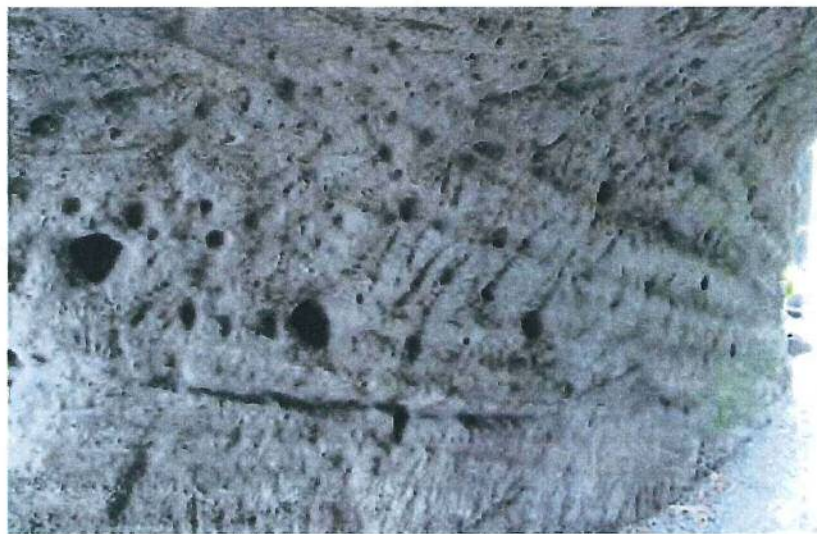
トンネル内部
