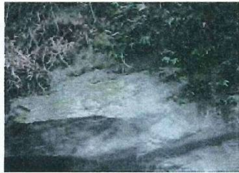
⑥北鎌倉側トンネル坑口上部 2
