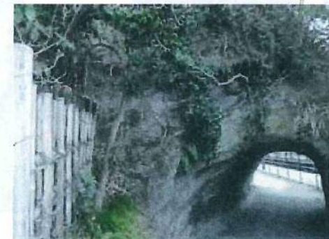
⑯大船側トンネル左上部
