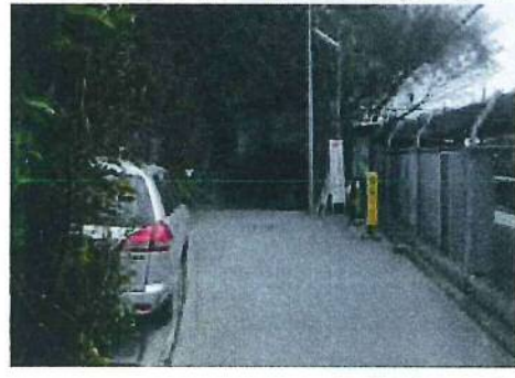
㉓大船側トンネル遠望 1
