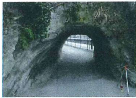
⑬大船側トンネル坑口
