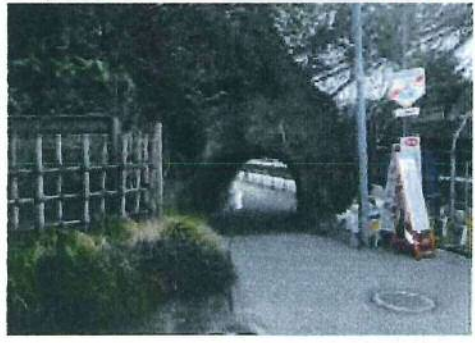
㉒大船側トンネル全景
