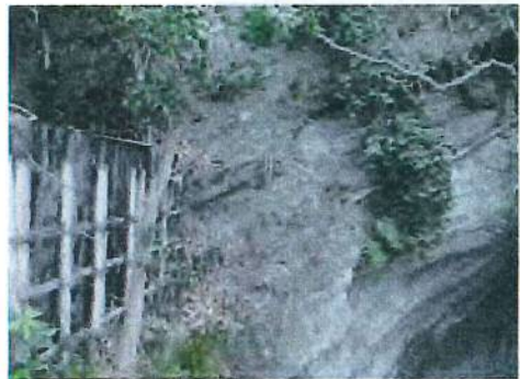
⑰大船側トンネル左肩部
