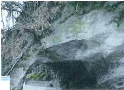
⑤北鎌倉トンネル坑口上部 1
