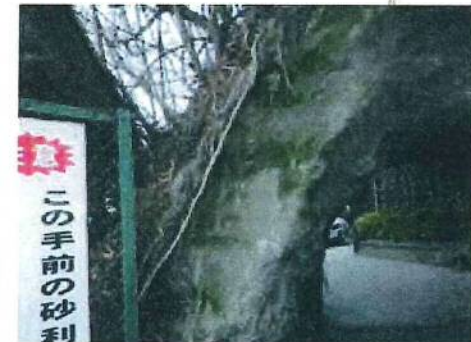
④北鎌倉トンネル坑口左肩部
