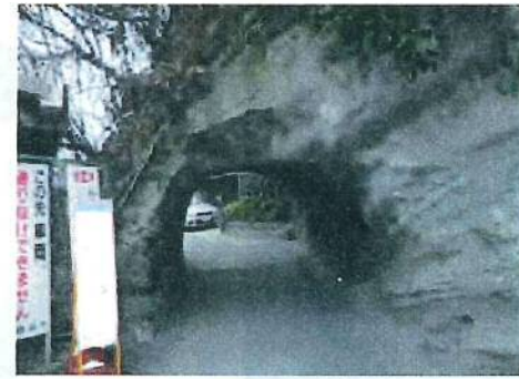
③北鎌倉トンネル坑口
