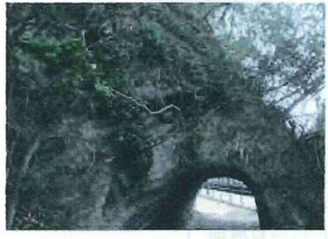
⑱大船側トンネル坑口上部地山状況 1
