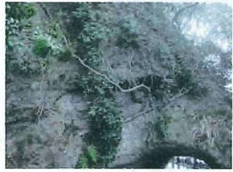
⑲大船側トンネル坑口上部地山状況 2
