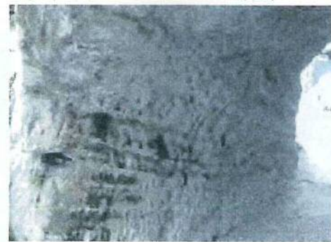
⑪北鎌倉側トンネル内左側壁
