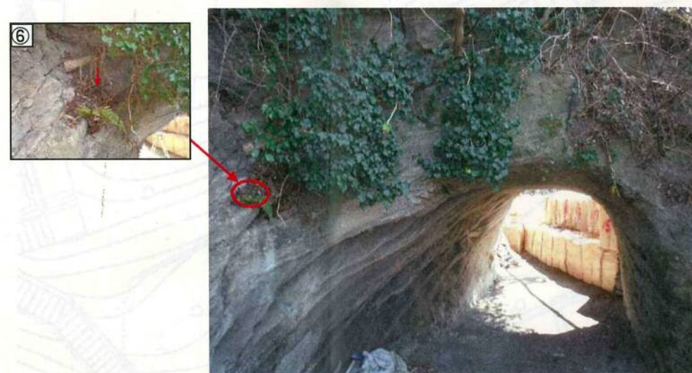
写真3-2 根茎の採取箇所 (大船側坑口)
