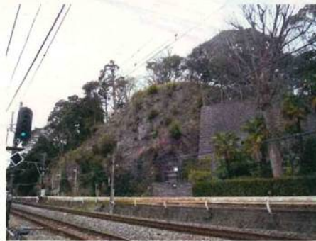
トンネル周辺での厚ネット工の施工事例 (参考)
