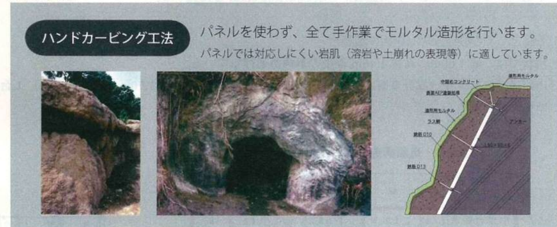
図5-7 ハンドカービング工法
