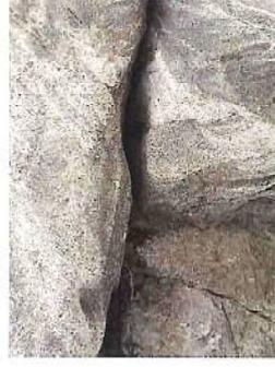
④トンネル内部亀裂から木の根
