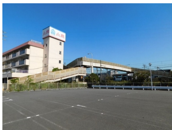
小袋谷歩道橋
