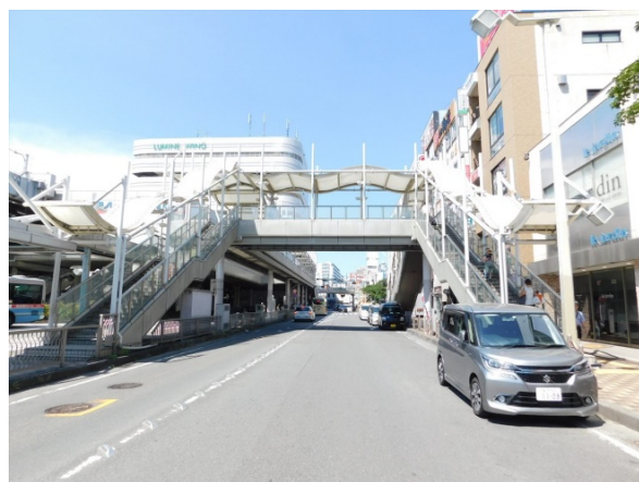
大船駅東口1号歩道橋
