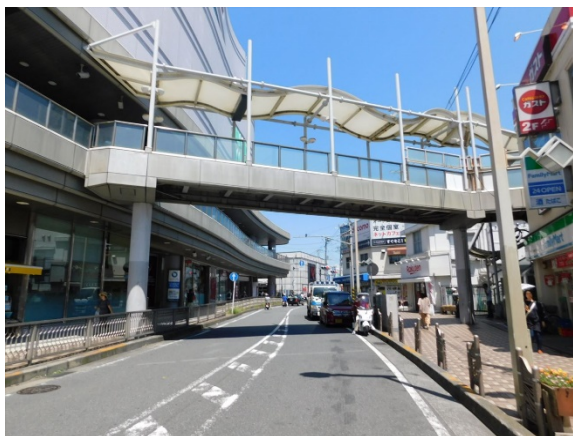
大船駅東口2号歩道橋
