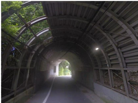
無名トンネル
