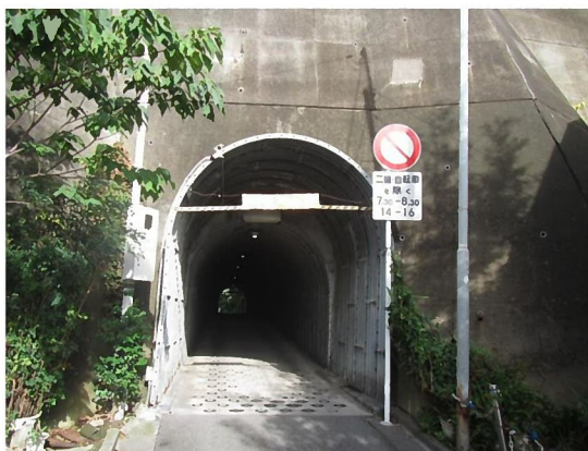
岡本塩原隧道
