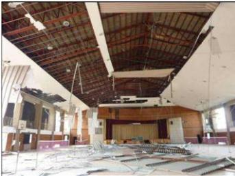
地震によって、天井材が全面的（部分的）に落下した大変危険な事例です。
