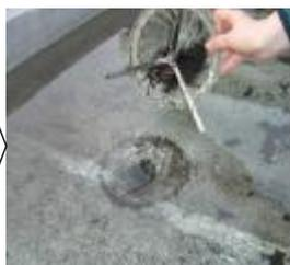
樹木の葉や枝がルーフドレインに詰まり、屋上面がプール状態になってしまう大変よくある事例です。屋上に溜まった雨が、劣化した防水層から侵入して、天井への漏水や設備機器の漏電被害の原因になります。清掃しましょう。
