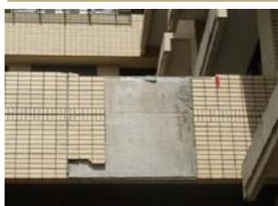
外壁タイルの一部が浮きにより、構内通路に落下した大変危険な事例です。
