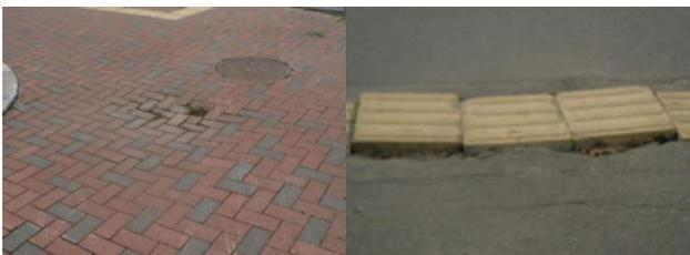
インターロッキングの陥没（左）、視覚障害者誘導ブロックの不陸（右）の事例です。歩行者や施設利用者への通行上の安全を確保する対策を行うとともに、地中に埋設された設備配管等の漏水等に問題がないか確認する必要があります。
