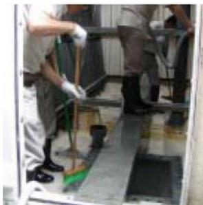
空調設備（冷却塔等）については、レジオネラ属菌などの細菌類を増殖させないための工夫が必要です。また、冷却塔の位置が外気取入口や窓に近い場合は、飛散した冷却水のエアロゾル（細かい水滴）が空調機を介して室内に取り込まれることにより、レジオネラ症等が集団発生する可能性がありますので、エアロゾルをできるだけ飛散させないよう十分な管理が求められます。
