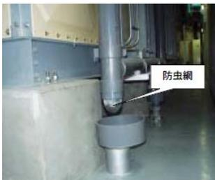
オーバーフロー管、通気管の防虫網が破損していないか確認します。防虫網が破損していると水槽内部に虫や鳥などが入り込み、飲み水が汚染されることがありますので、必ず補修しておきましょう。また、排水ドレン管と接続されたタイプのオーバーフロー管では、清掃時の排水で防虫網が破れたり、防虫網の内側に塗料や錆が溜まって抜け落ちたりしやすいので注意が必要です。
