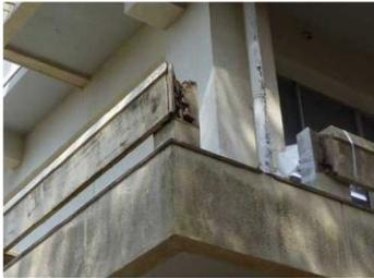
老朽化によって手すりが破損し、児童・生徒の転落事故に繋がった大変危険な事例です。
