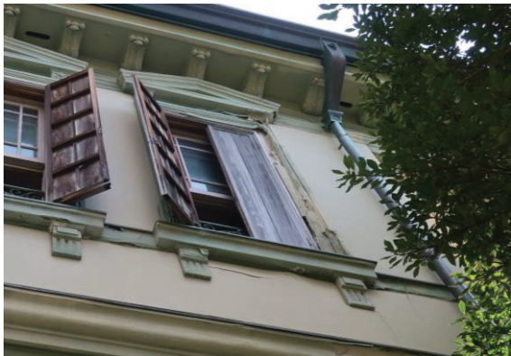
⑧窓枠装飾、⑨漆喰壁
