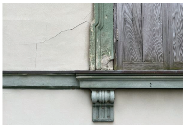
④窓枠装飾、⑤漆喰壁
