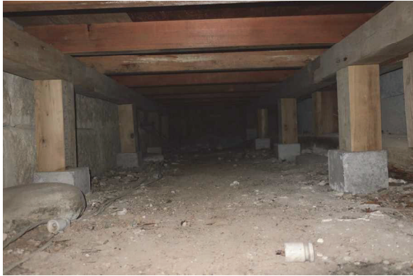
1 階床下（大引・根太まわり／改修前後の構造体まわり）
