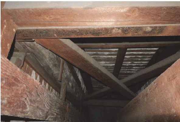
2 階 柱、筋交い（柱／筋交い）
