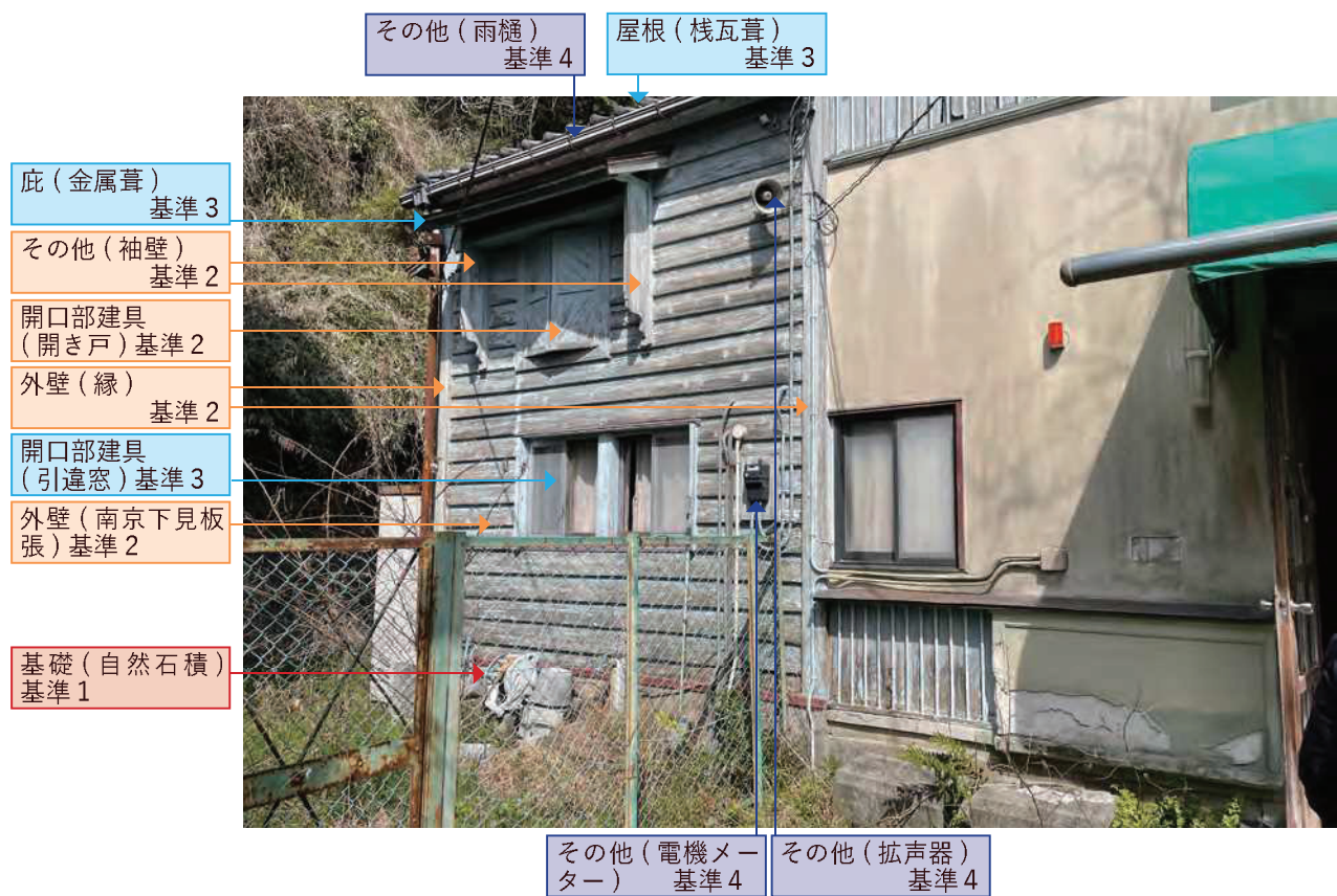
蔵 西側立面【保存部分】
