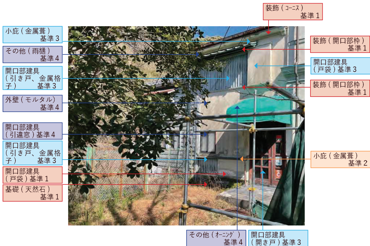
洋館 (附属棟) 西側立面【保存部分】
