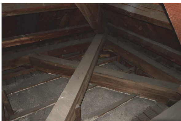
小屋裏（軒桁・梁まわり／棟木・真束まわり）
