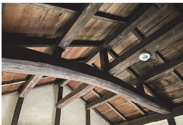
小屋裏（軒桁・梁まわり／棟木・束まわり）
