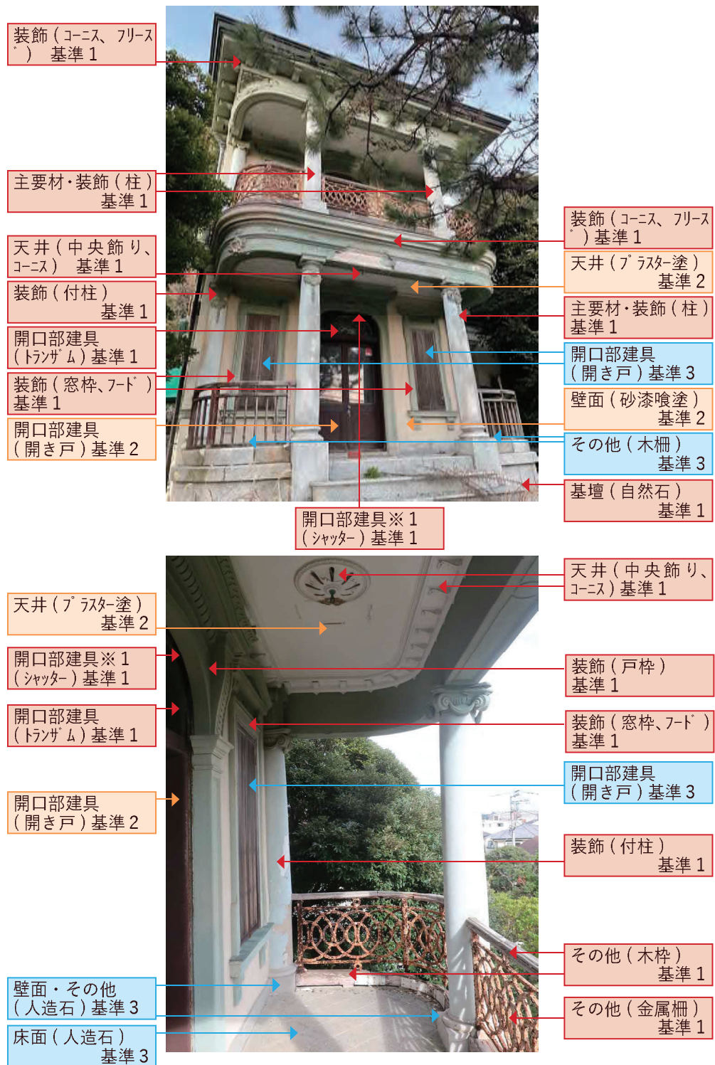
洋館（本館） 南側立面【保存部分】
