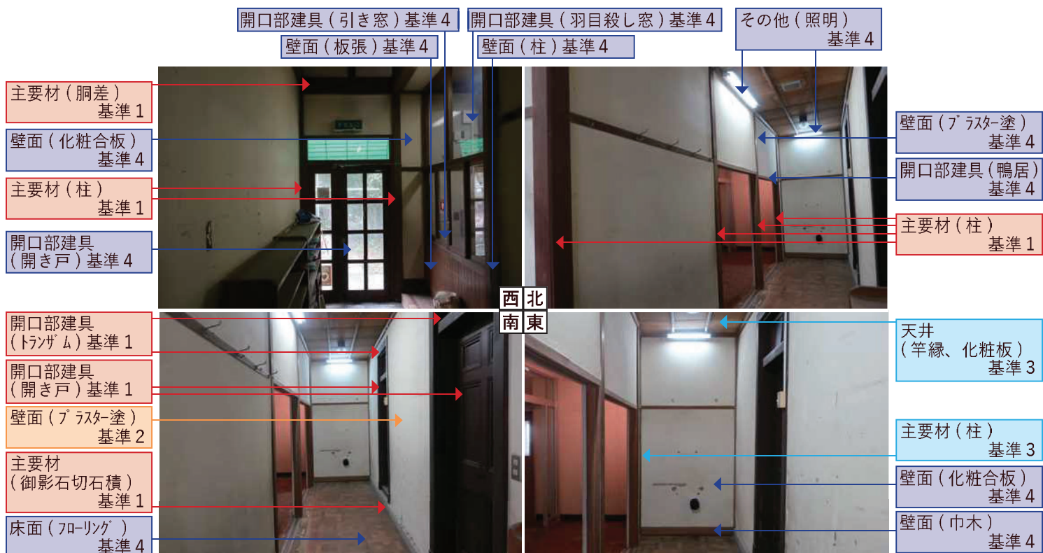
洋館 (廊下) 一階【保全部分】
