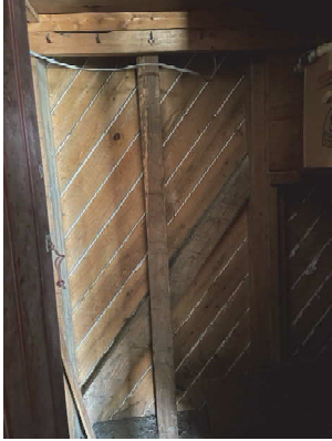
1 階 柱、筋交い（柱／筋交い）
