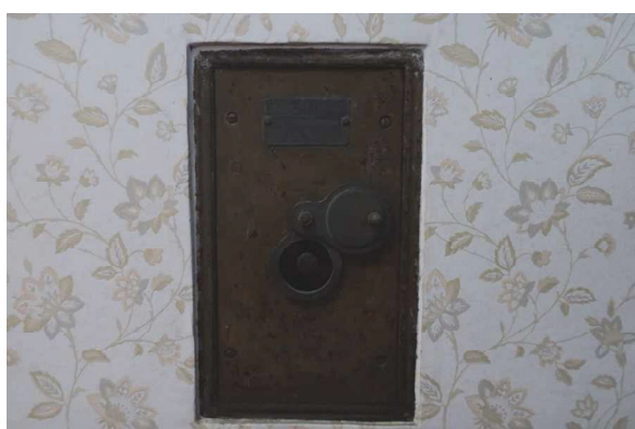
2 階バルコニー シャッター
