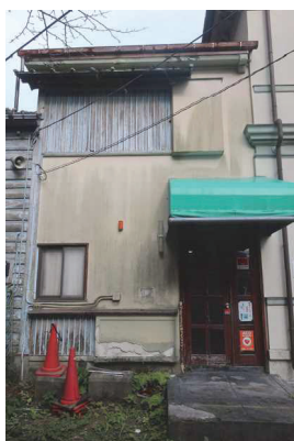
外観（壁：西側／壁：東側）
