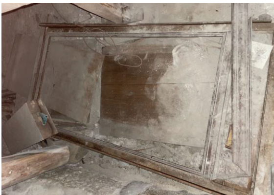
開口部とみられる下地の型枠
