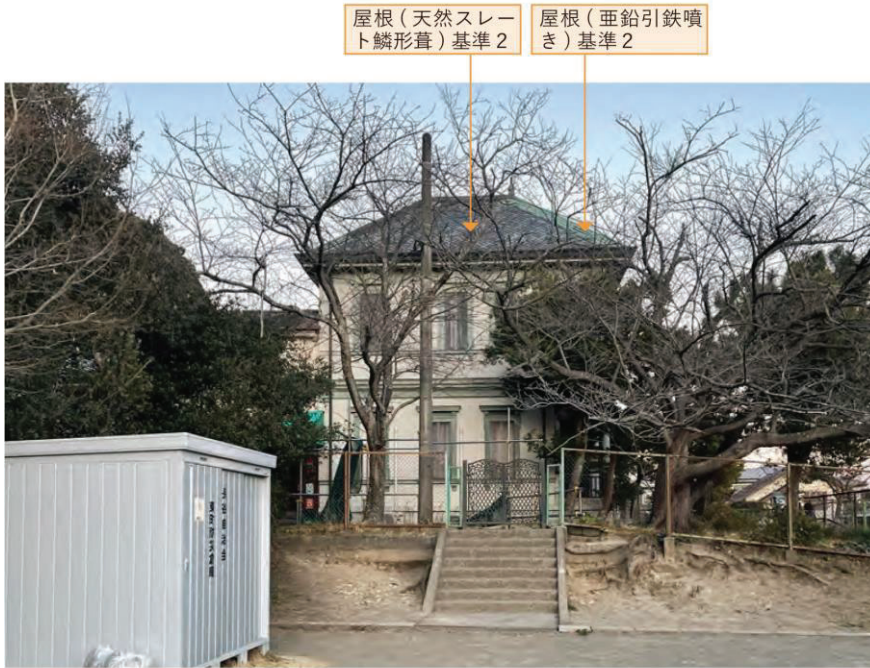
洋館(本館)屋根面【保存部分】
