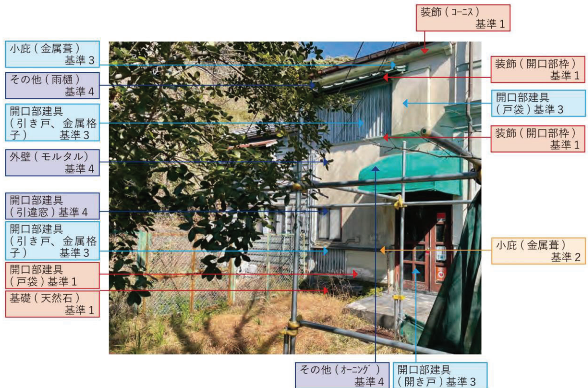
洋館（本館）附属棟西側立面【保存部分】
