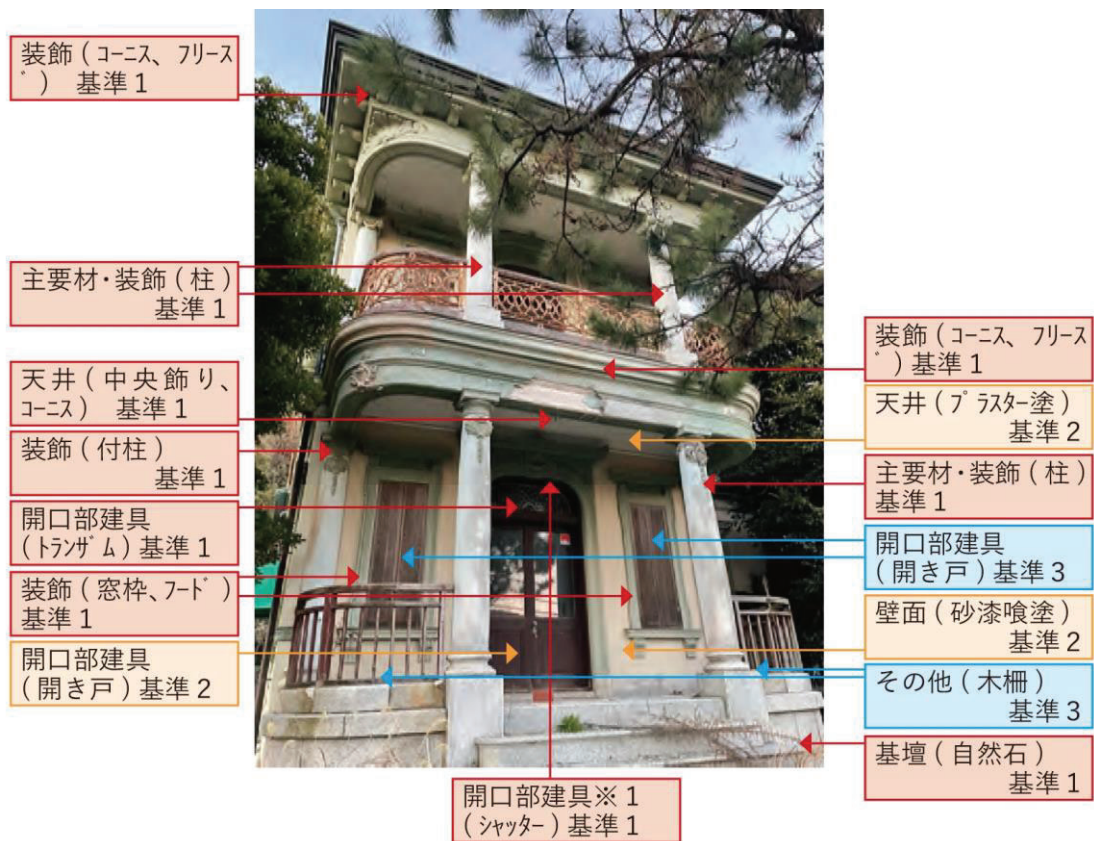
洋館（本館）南側立面【保存部分】
