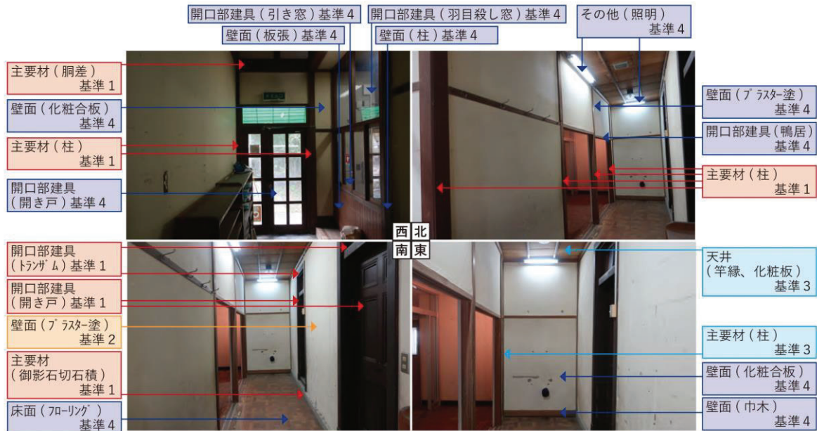
洋館（廊下）【保全部分】
