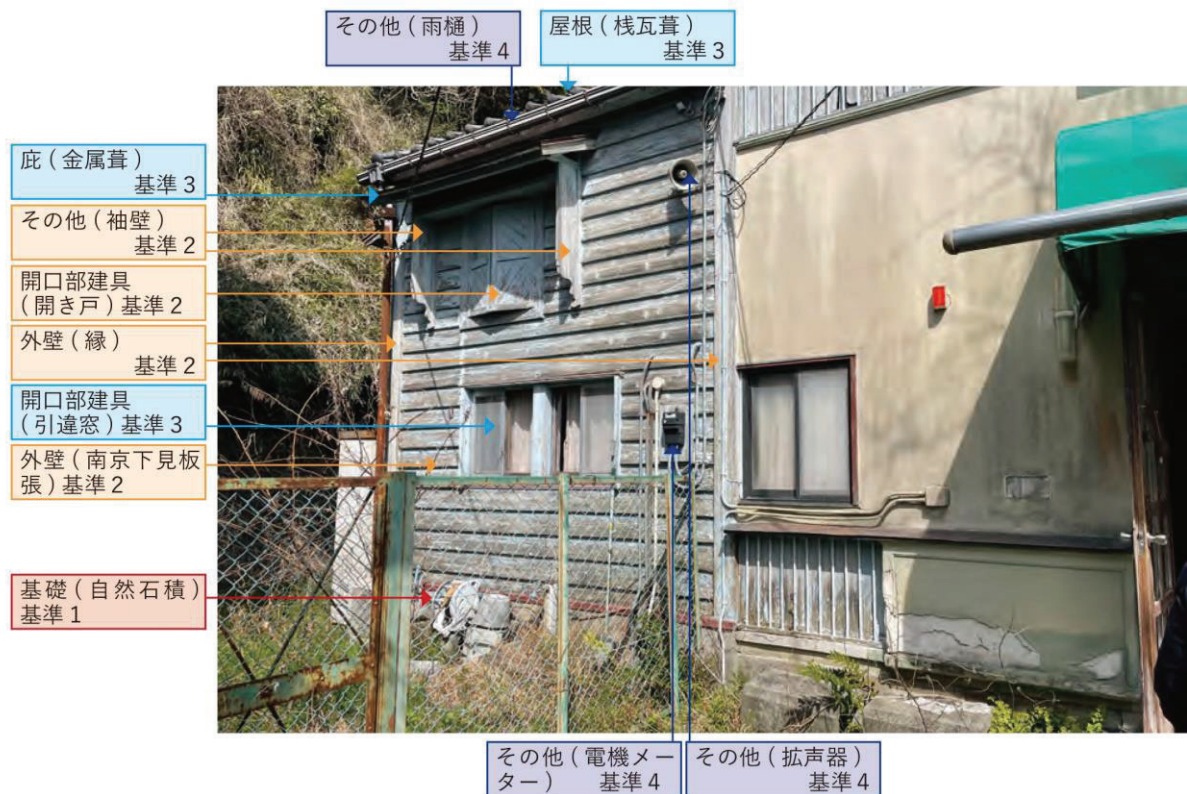
洋館（本館）附属棟西側立面【保存部分】
