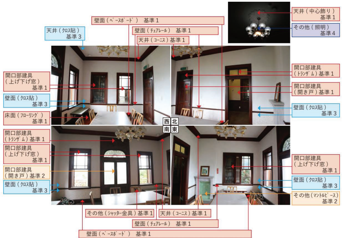
洋館(本館)二階 洋室3【保存部分】
