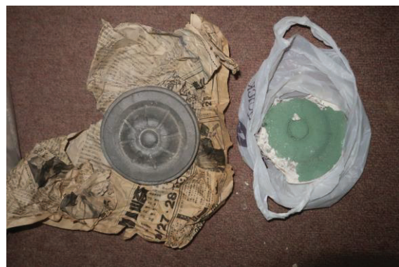
外壁に施されているモチーフの型枠、劣化した現物
