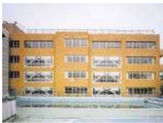
ブレース補強外観
