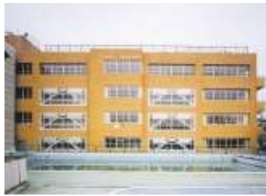
ブレース補強外観
