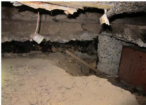
9通り付近:埋土沈下2
