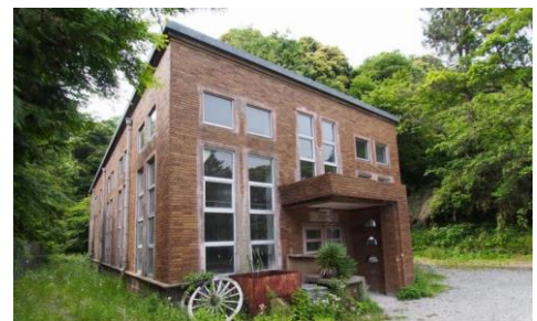
写真2-107 旧神奈川県営湘南水道鎌倉加圧ポンプ所
