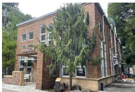
写真2-237 旧神奈川県営湘南水道 鎌倉加圧ポンプ所
