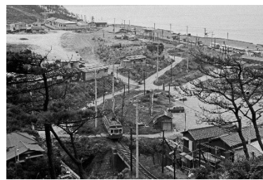
写真2-193 行合川の橋梁 (昭和42年(1967年))
