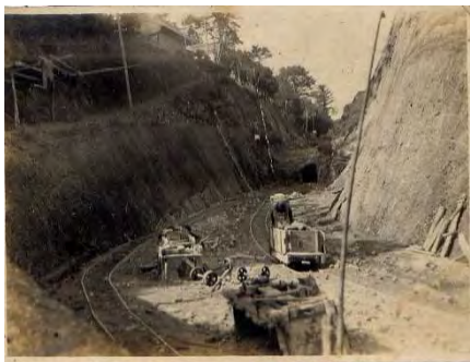
写真2-265 昭和の工事の写真 (昭和48年(1973年))
