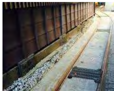
写真2-171 トロッコ用レール
