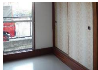
改修後(1階和室の洋室化:段差解消)
