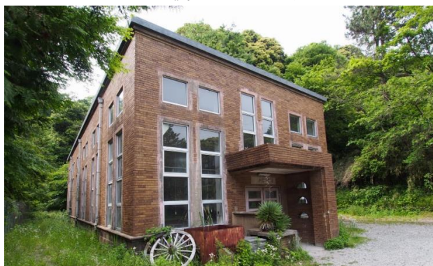
旧鎌倉加圧ポンプ所
